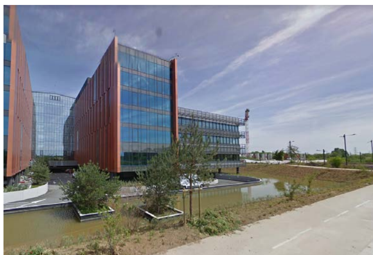
Avenue des Louveresses, Groupe Up, Gennevilliers
