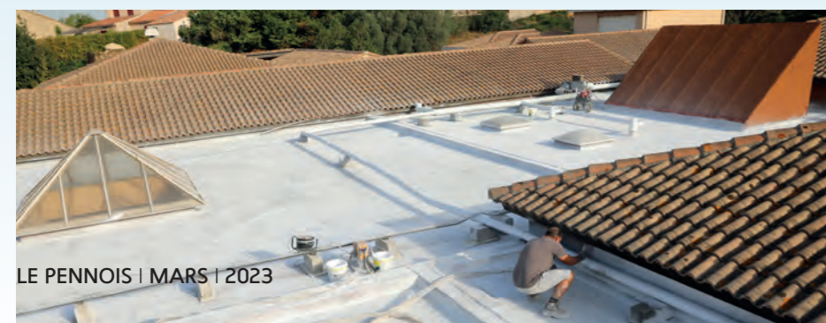
Travaux d'isolation thermique de l'école de La Renardière.
