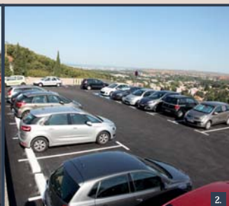
Une réfection du niveau supérieur du parking, avec reprise de l'enrobé et traçage de places a été réalisée (photos 1 et 2). Par ailleurs, une reprise des pavés de certaines rues a été effectuée (photo 3).
