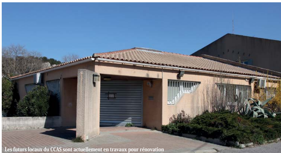
Les futurs locaux du CCAS sont actuellement en travaux pour rénovation
