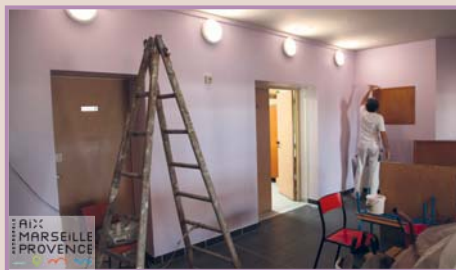
ÉCOLE LA RENARDIÈRE Les Services techniques ont repeint le hall du groupe scolaire de La Renardière.
