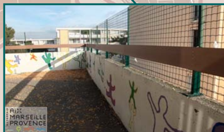
MATERNELLE SAINT-GEORGES De nouveaux garde-corps ont été mis en place par les Services techniques dans la cour de l'école maternelle.
