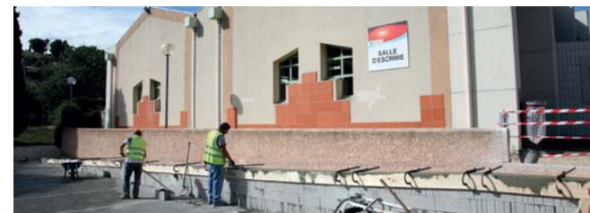
Mise en place d'une rampe pour les personnes à mobilité réduite
