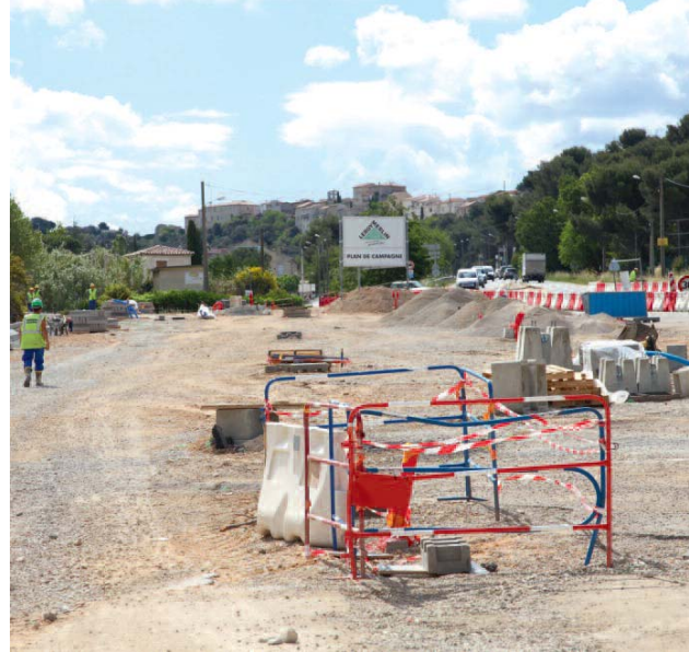
Le chantier du futur parc relais de Pallières
