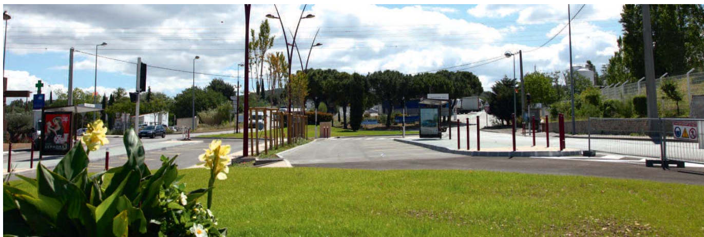
Le pôle d'échanges du square Général de Gaulle
