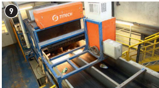
9 Le flux des corps creux rejoint un tapis à grande vitesse sur lequel un faisceau lumineux est projeté. Le spectre réfléchi par les objets est scanné par la machine de tri optique pour déterminer la matière qui le compose. Cette information est envoyée à des buses à air comprimé qui éjectent les déchets en fonction de leur nature : les bouteilles et flacons en plastique opaque (PEHD) ainsi que les
