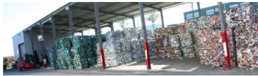
11 Les matières à conditionner sont stockées dans des boxes qui sont vidés automatiquement depuis le poste de conducteur de presse à balles ; seuls les journaux et magazines restent en vrac. Les balles (cubes) sont conservées sous un auvent extérieur avant évacuation vers les entreprises de recyclage. Les refus de tri sont aussi mis en balles pour être dirigés vers l'installation de stockage de déchets non dangereux ou vers des usines d'incinération. Le centre produit 50 à 100 balles par jour.
