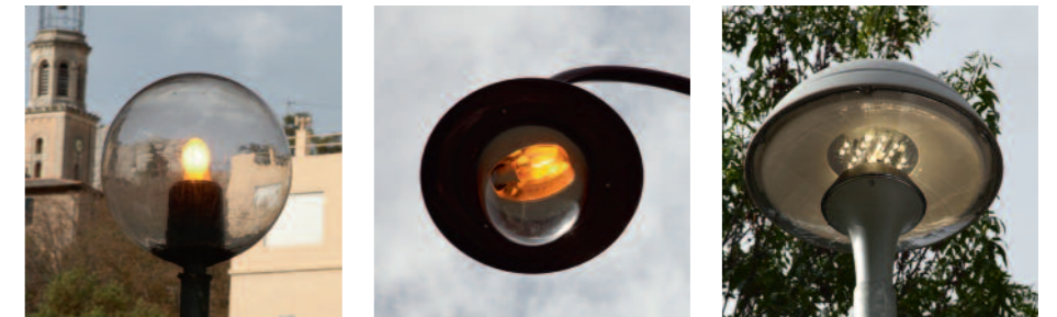
Ci-contre : Horloge astronomique dans son armoire électrique Ci-dessous : Lampe à vapeur de mercure, lampe à vapeur de sodium et lampe LED.
