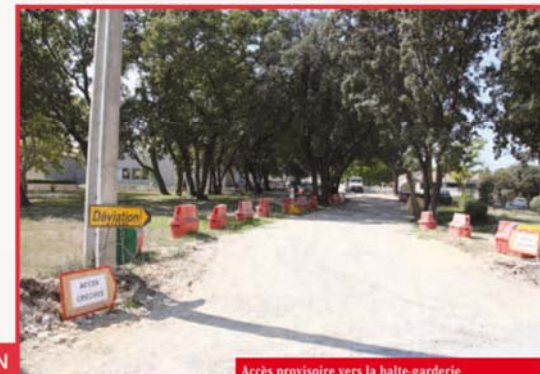
Accès provisoire vers la halte garderie
