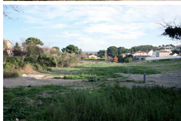
Le bassin de rétention de La Gavotte
